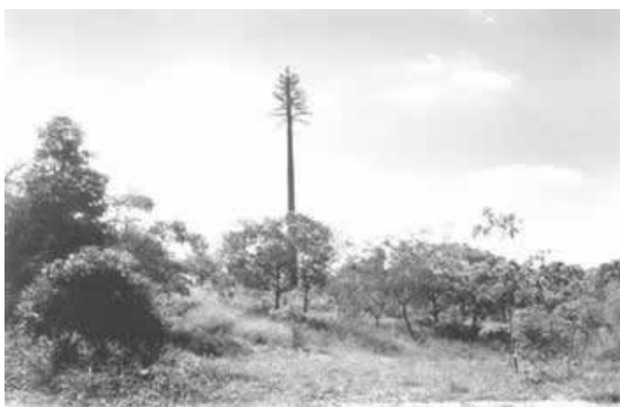
Figura 5. Torre camuflada da UFMG
