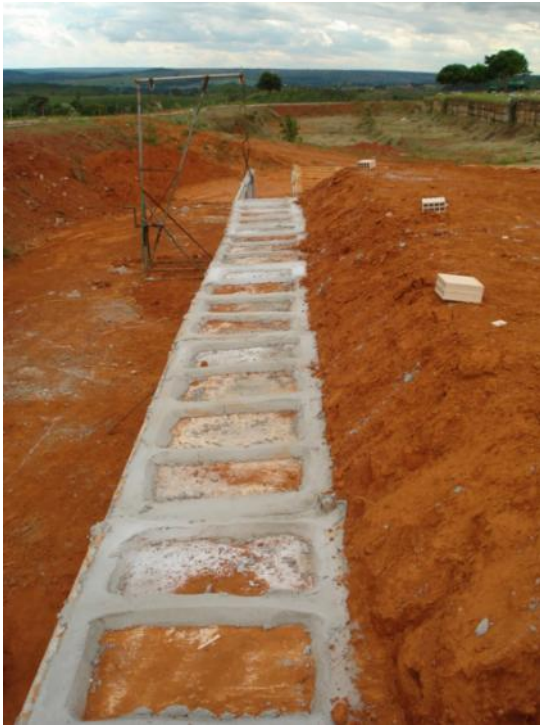
Figura 3: Fase inicial da construção dos jazigos.
