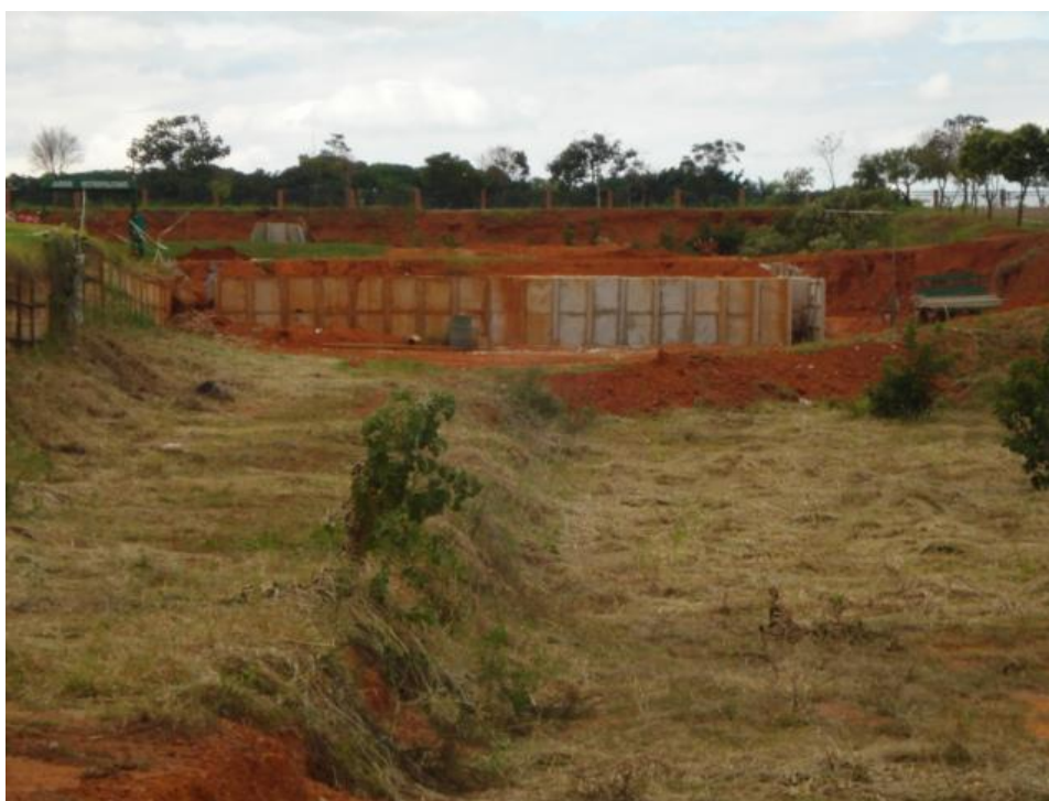
Figura 7: Vista parcial demonstrando a construção dos jazigos acima do solo.
