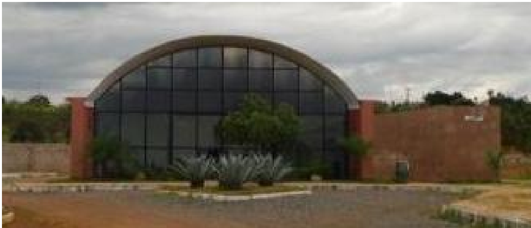
Figura 2: Vista frontal do crematório
